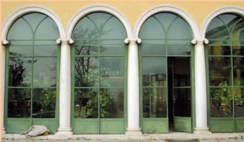
Palazzo Carini - Quecchia - particolare del portico con arcate
