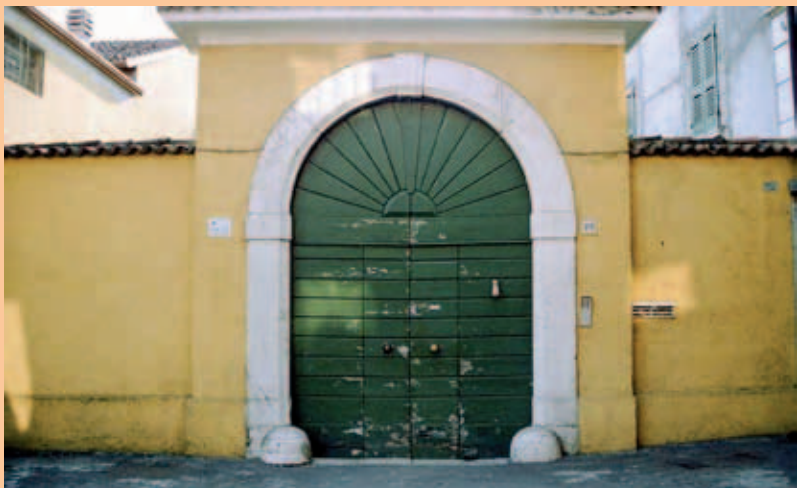
Palazzo Carini - Quecchia - portale esterno
